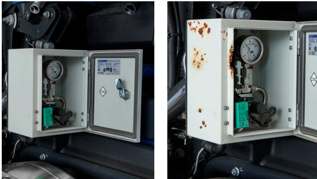
Rozsda a töltőcsatlakozó védődobozon → feljegyzés kiszámlázás nélkül.
