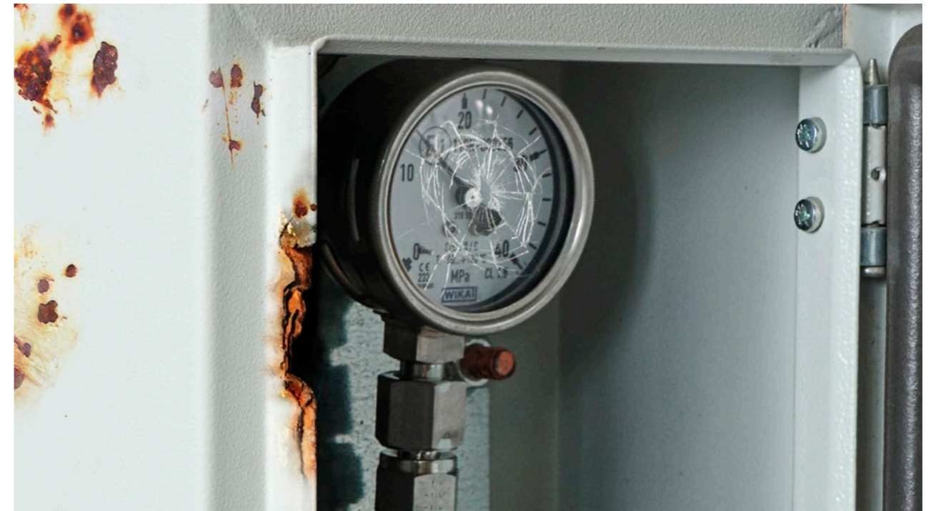
Hiányzó védőszekrény kulcs, sérült CNG csatlakozó vagy nyomásmérő → a teljes szekrény csereköltése az ügyfelet terheli.
