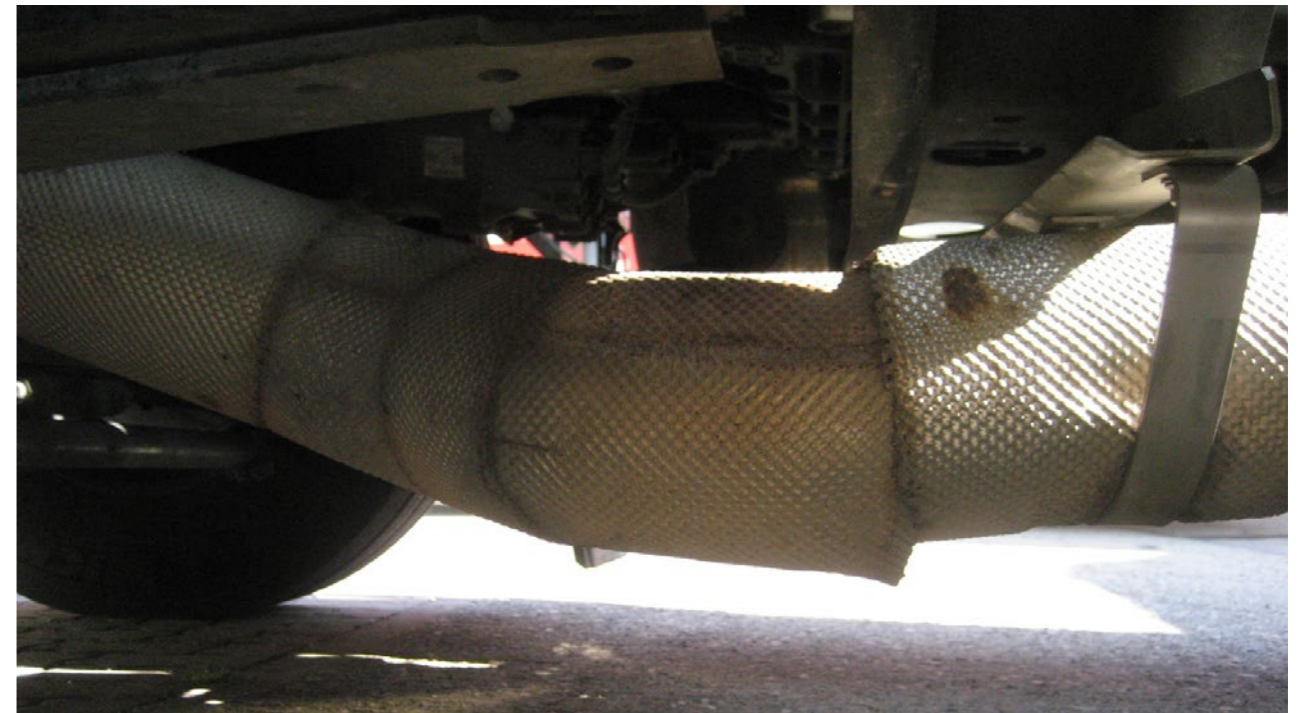
A következők nem elfogadhatók: törött csövek, elszakadt hőszigetelés, mély karcolások az anyagban, horpadások, amelyek csökkentik a cső átmérőjét.
